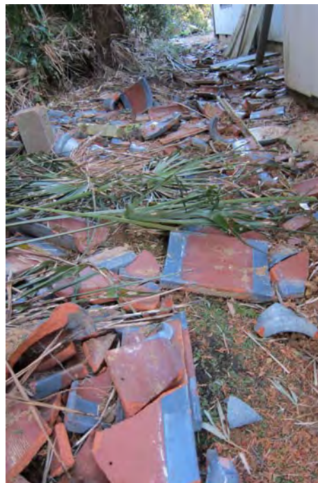
写真7．落下した瀬戸瓦（いわき市泉町） （3月27日筆者撮影）
