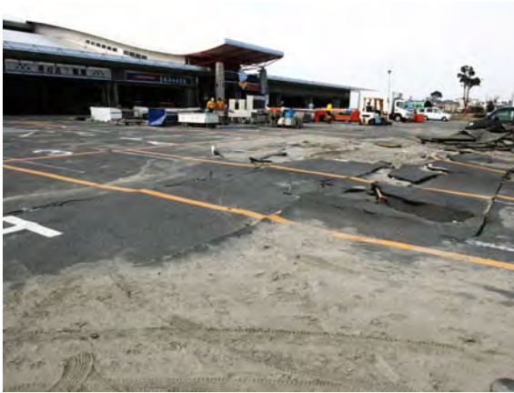
写真2. アスファルトの隆起・破損 (3月29日筆者撮影)
