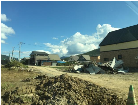
写真7 倒壊した倉庫
