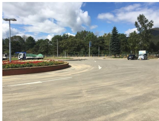
写真2 道の駅の駐車場
